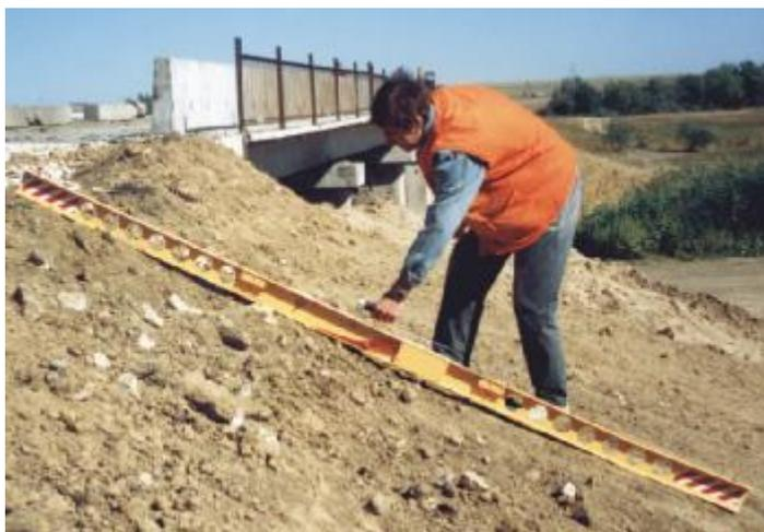
*Рис.10. Определение коэффициента заложения откоса земляного полотна с помощью универсальной рейки*
